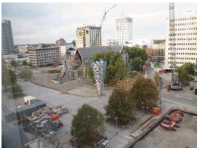
今年3月末頃の クライストチャーチ大聖堂解体現場 復元するかは未決定
