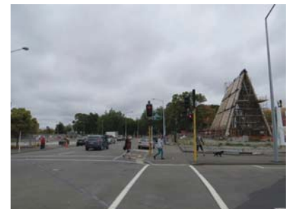
右側が仮設大聖堂、道路を挟んで 左側が地震で日本人留学生が 多数亡くなったCTVビル跡地
